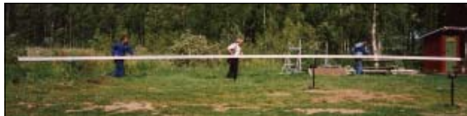
Hängrännan kan bli i princip hur lång som helst utan onödiga skarvar vilket minskar risken för läckage.
