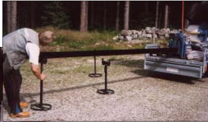
Hängrännan körs ut i rätt längd, anpassad efter Ditt hus och kapas till.
