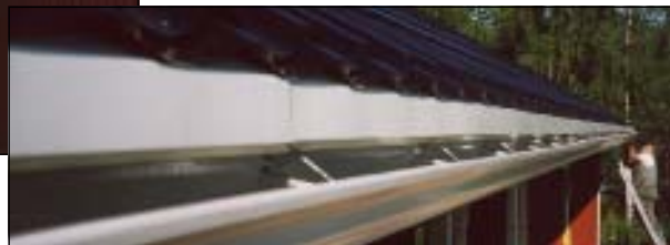
Hängrännan kan bli i princip hur lång som helst utan onödiga skarvar vilket minskar risken för läckage.
